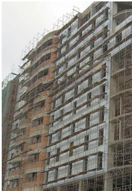
EDIFICIO RESIDENZIALE - TIRANA - ALBANIA
